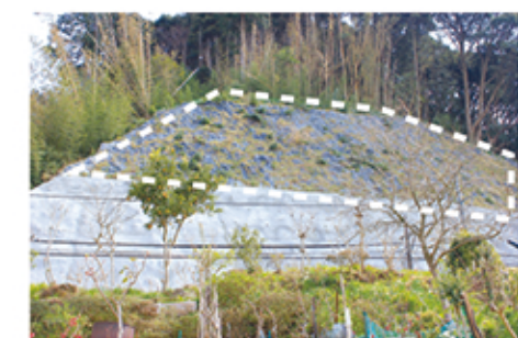
点線で囲った面が徐々に緑化していきます。
